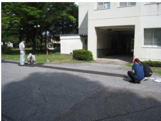
排水溝の点検
