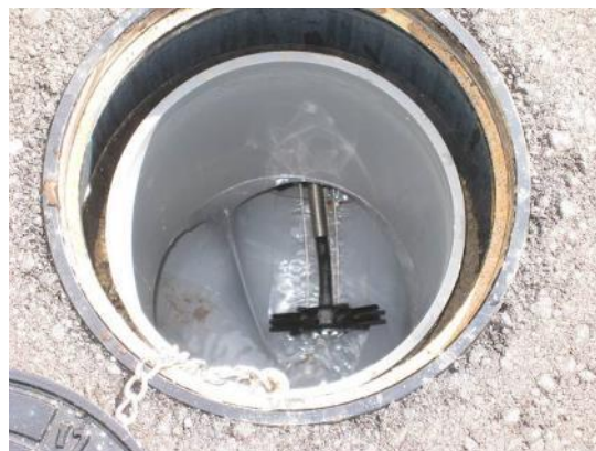
排水ますの内部
