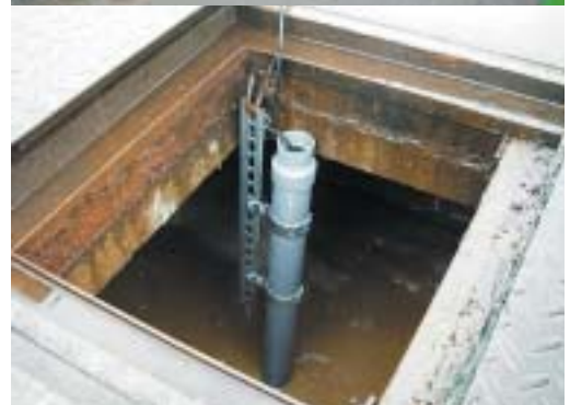
曝気槽へのDO計設置
