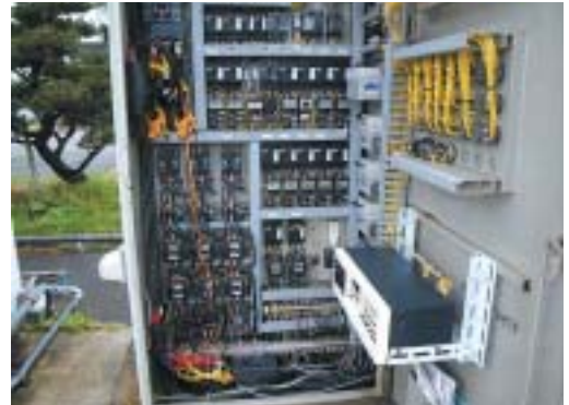
排水処理施設用配電盤への電力量計設置
