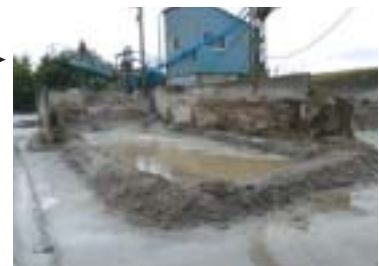
地盤改良材の原料として再利用
