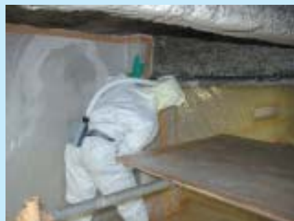
アスベスト飛散防止対策の確認調査
