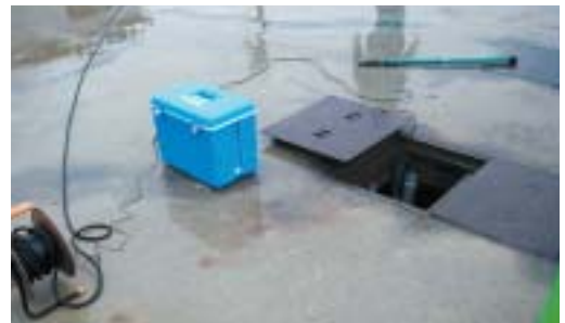
排水処理施設用配電盤への電力量計設置
