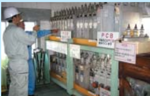
PCB 保管状況の確認調査
