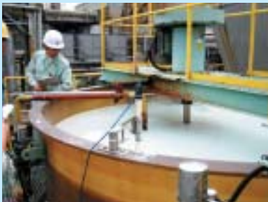
排水処理施設における稼働状況の確認
