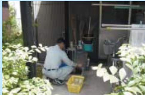
地下水水質調査
